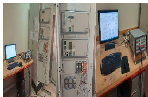
شکل (۱۷): تصویر تست‌های عملی رله دیستانس
