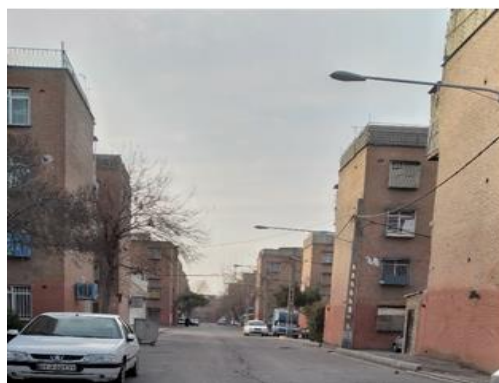
شکل ۲- نمایی از مسکن محدوده مطالعاتی (مجتمع آجر قرمزها)
