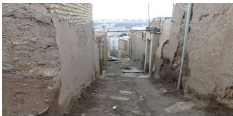
شکل ۵. نمایی از بافت فرسوده در محله‌های غربی شهر خرم‌آباد
