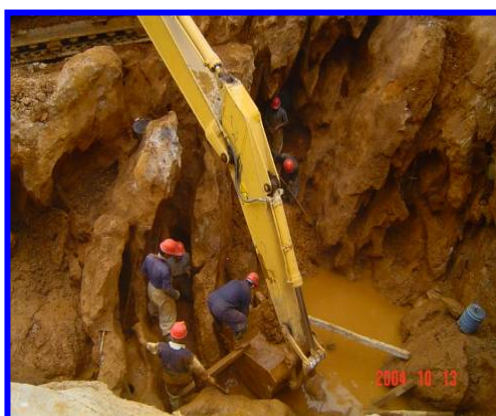
شکل ۶- عملیات شستشو و تخلیه حفرات کارستی حاوی رس در پی سنگ سد اکباتان
