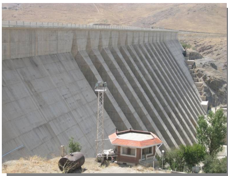
شکل ۱ - تصویر سد اکباتان پس از افزایش ارتفاع
