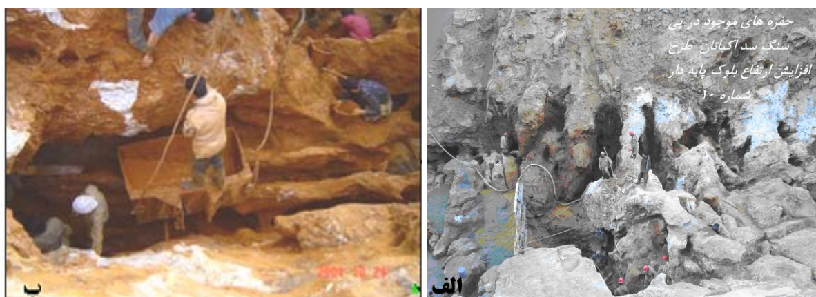
شکل ۱۰- مراحل آماده سازی حفره های سطحی به منظور بهسازی با تزریق سیمان
