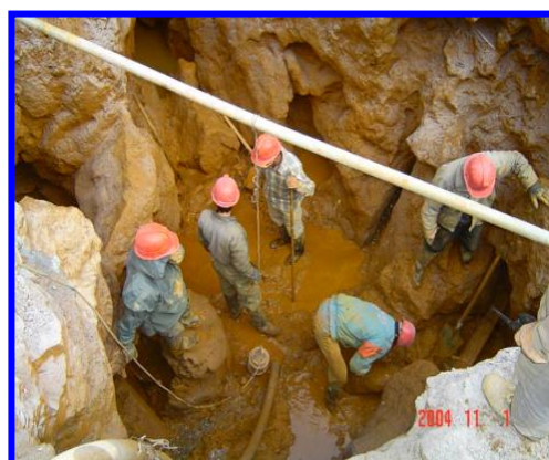
شکل ۶- عملیات شستشو و تخلیه حفرات کارستی حاوی رس در پی سنگ سد اکباتان
