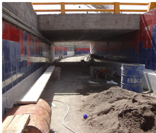
زیرگذر منطقه ۱۱ - بزرگراه میثاق
